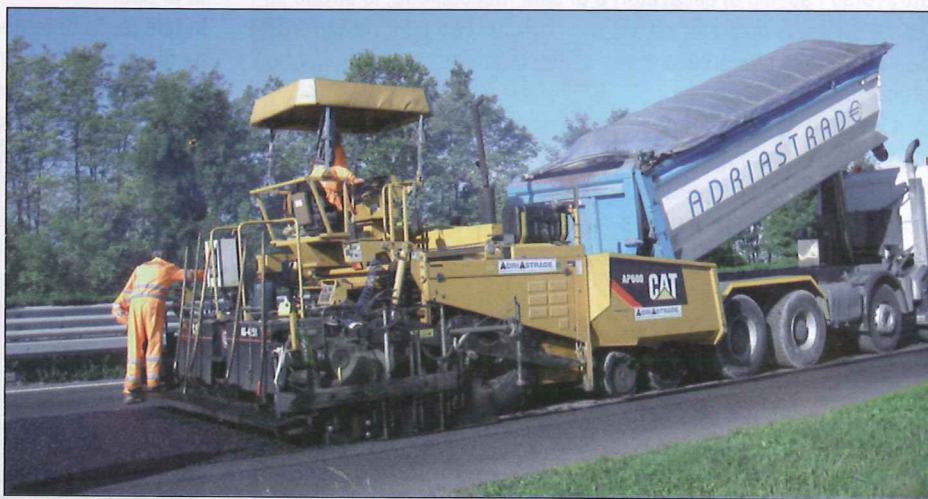
Figura 1 - La finitrice gommata AP600 in fase di carico del conglomerato
