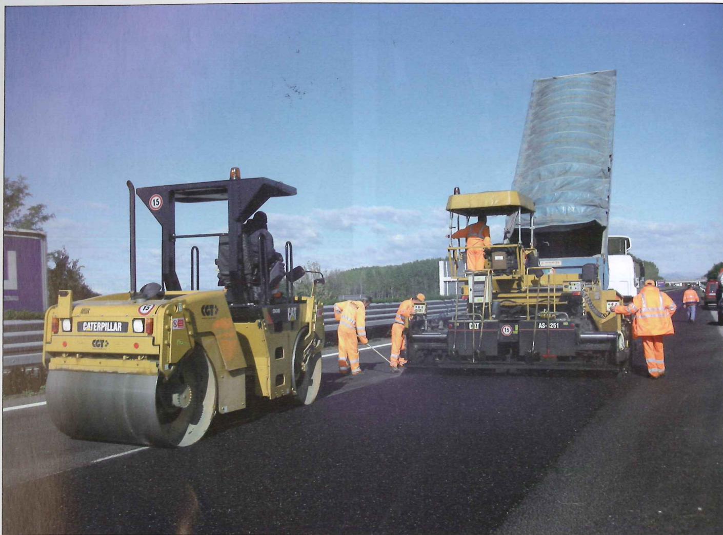
Figura 7 - Una visione panoramica del rifacimento del manto sull'Autostrada A23 Palmanova-Udine
