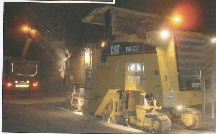
Figure 6A e 6B - La fresa Caterpillar CAT PM200 durante il lavoro notturno
