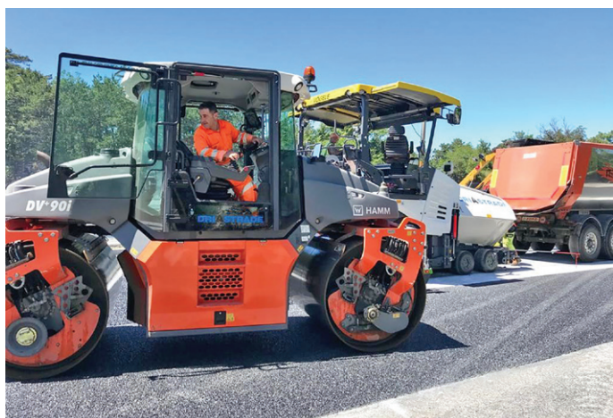
9. Il rullo tandem Hamm DV+90i VV-S durante la compattazione dello strato di usura drenante
