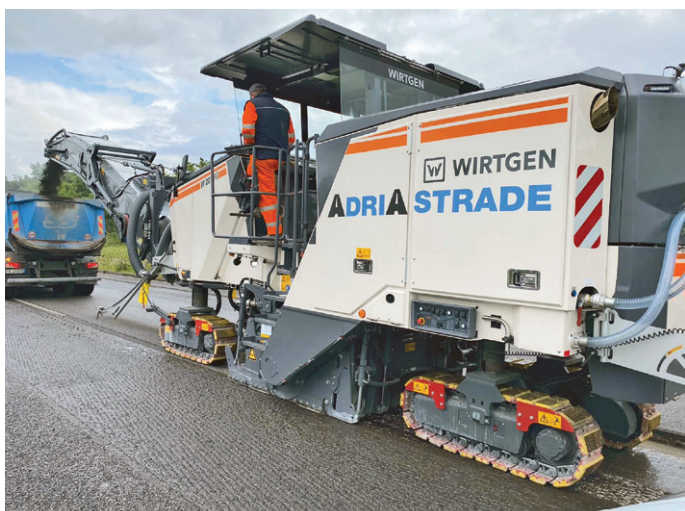
3. La fresa Wirtgen 207Fi all'opera
