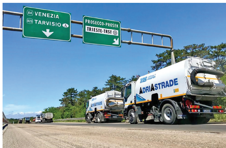
4. Un tratto dell'intervento
