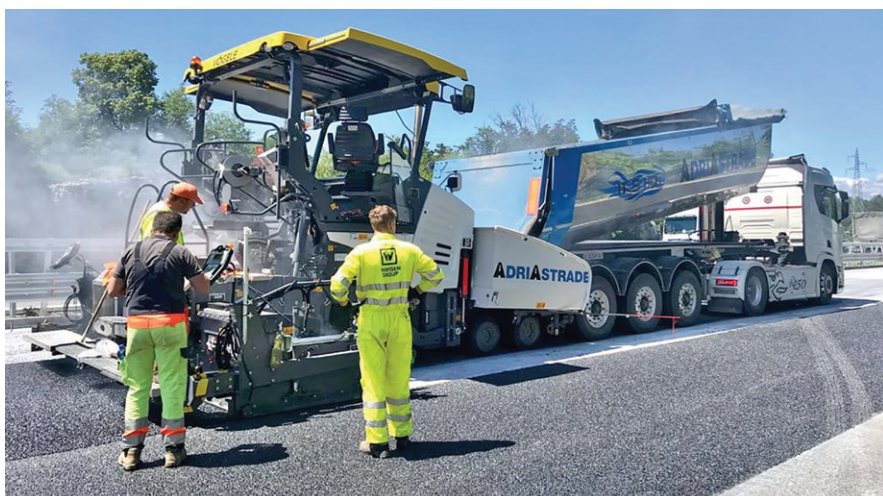
2. Il supporto tecnico fornito da Wirtgen durante le operazioni di stesa del manto drenante
