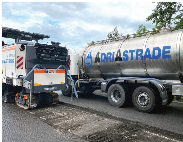
7. Il rifornimento di acqua in movimento durante le operazioni di fresatura
