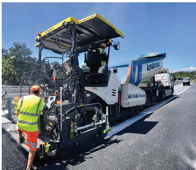
8. La stesa dello strato di usura drenante
