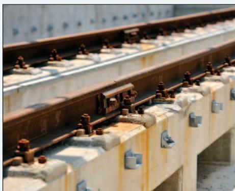
18. Un particolare del collegamento delle rotaie con le strutture rialzate in calcestruzzo
