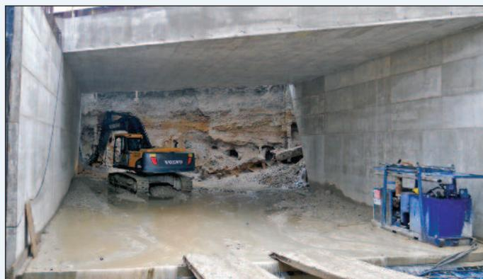
**28.** La fase di scavo all'interno del monolite, in primo piano i martinetti di spinta
